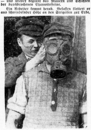
Vor der Arbeit in schwindelnder Höhe: Die Gasmaske wird angelegt.
