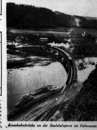
Eisenbahnbrücke an der Saaleletzperre bei Hohenwarte
