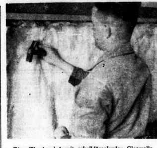
Eine Wand wird mit schalldämpfender Glaswolle ausgekleidet.
