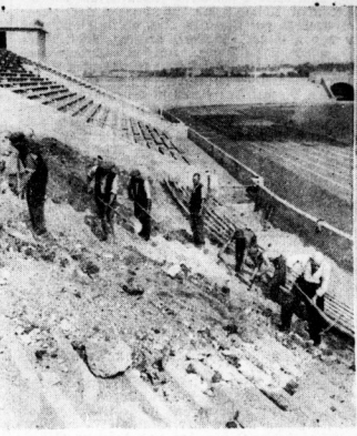
Von links nach rechts: Das neue Tor am Tribüneneingang. Hebung der Stehplatzterrassen, Verkleidung einer Säule mit Porphyryplatten. - (Aufnahmen: Danz)
