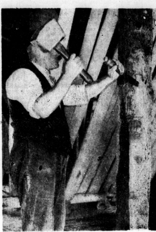
Vom „Hausbock“ angegriffenes Balkenwerk wird bearbeitet. (Aufnahme: Danz)
