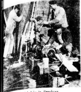
Beim Bau der Saalbrücke in Bernburg
