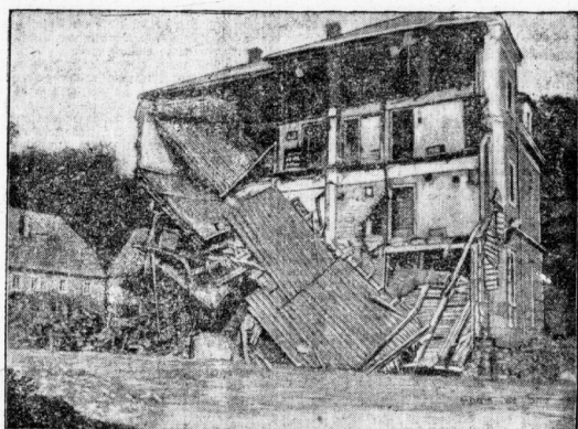
Oden: Ein freischwebendes Dach in Bergschichten. Ganze Häuserfronten sind von den Fluten unterwühlt und vom Sturm aufgerissen worden. Innen: Die Fußböden dreier Stockwerke hängen vom Giebel bis zum Boden gleich einer riesigen Wasserleitungsröhre. Die Balkenwand des Erdgeschosses ist weggerissen.
