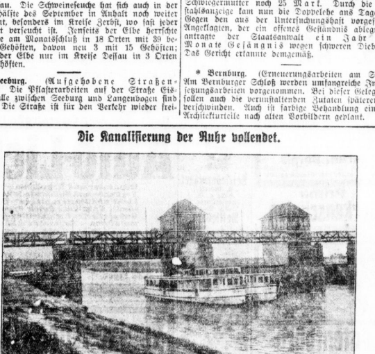
2200 Tonnenn Schiffe können in Weidenfels laden. Die Kanalisierung der Angrz vollendet.
