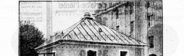
Ein ganz aus Stahl gebautes Einfamilienhaus erregt auf der Werkstoffschau große Aufmerksamkeit.
