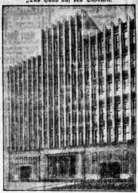
Das neue Haus des Gesundheitsamts in Hamburg falls dem geplanten Zug einer modernen Suedban. Das Gebäude ist über der Bahnhofsmauer der Untergrundbahn in Hamburg errichtet, ohne daß der Betrieb und der Fahrplan der Hamburger Untergrundbahn dadurch geändert und gehöhrt wurde.
