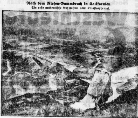
Der gebrochene Damm Francis-Damm mit dem Santa Clara Tal.
