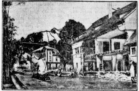
Straße in Berggleisbübel nach der Katastrophe des Vorjahres.
