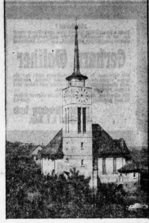
Die fertige Kirche, wurde die neue Lutherkirche dieser Tage eingeweiht. Die Kirche ist das Werk des hallischen Architekten Dr. H. Ostermaier.
