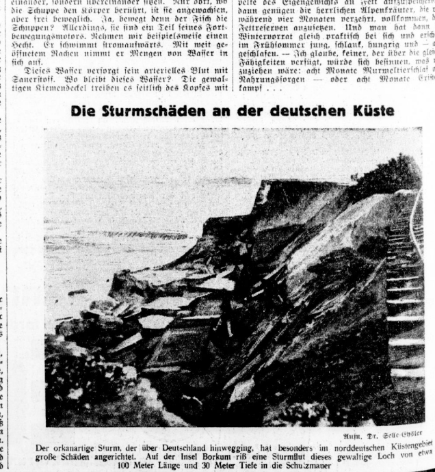
Der orkanartige Sturm, der über Deutschland hinwegzog, hat besonders im norddeutschen Küstengebiet große Schäden angerichtet. Auf der Insel Borkum rief eine Sturmflut dieses gewaltige Loch von etwa 100 Meter Länge und 30 Meter Tiefe in die Schützmauer.
