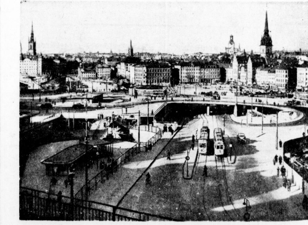
In der schwedischen Hauptstadt hat man zur Bewältigung des ständig anwachsenden Verkehrs eine Zwei-Etagen-Straße geschaffen, deren Bau sich vortrefflich in das Straßenbild Stockholms einfügt. Unser Bild zeigt einen Blick auf die Hochstraße.
