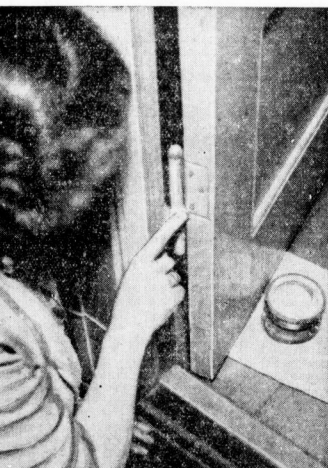
Wenn die Tür quietscht, muß man die Angeln gut einfeilen. Am besten verwendet man feste Fette, weil flüssige in der Sonnen- und Zimmerwärme leicht eintrocknen würden: Reines Stadtrindenfett
