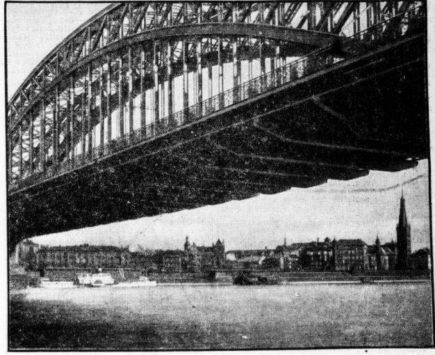
Bei Düsseldorf / Die Rheinbrücke mit dem Blick auf die Altstadt
