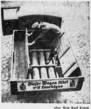
Ein Gas-Kraftwagen, der mit Leuchtgas betrieben wird. Die Flaschen sind unter dem Wagenkasten angeordnet. Bei den Fahrversuchen hat sich ergeben, daß 17 bis 1,8 cm Gas diese Leistung erreicht, wie 1 Liter Benzin-Benzolgemisch. Dabei würde sich der Gaspreis zum Benzin-Benzolpreis wie 1,87 zu 33 Pfennig verhalten. Das bedeutet eine Ersparnis von 40 Prozent.
