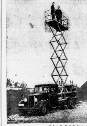
Wohnung in Holland hat sich ein fähiger Kopf diese praktische Erfindung patentieren lassen. Die auf einem Auto montierte und dadurch leicht bewegliche Kanzel wird durch eine einfache Vorrichtung hochgezogen. Die praktische Einrichtung wird voraussichtlich eine größere Anwendungsmöglichkeit finden, als man im Augenblick anzunehmen geneigt ist. Für Redner, für Bildhändler erster usw. ist sie jedenfalls von erheblichem Vorteil.
