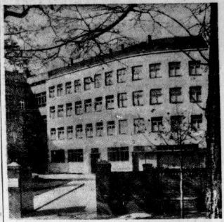
Aufnahme: Rudolf Krieb Das Gebäude der Lebensversicherungssanstalt Sachsen-Thüringen-Anhalt in Merseburg an der Ecke Hindenburg- und Lauchstädter Straße hat ein neues Gewand bekommen; der Anstrich - ein vornehm, heller Elfenbeinton - ist sehr vorzüglich und geschmackvoll ausgewählt worden und gibt dem Straßenbild seine besondere Note
