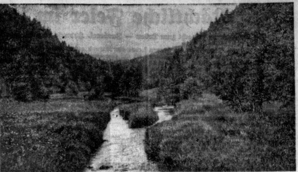
Einfluß der Rappbode in die Hauptbode. Hier wird die Staumauer der neuen Hartzaltalsperre erbaut. Ueber das Projekt haben wir kürzlich bereits berichtet
