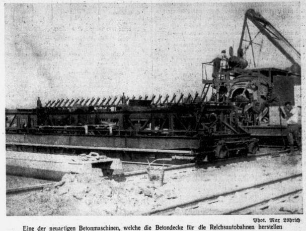
Eine der neuartigen Betonmaschinen, welche die Betondecke für die Reichsautobahnen herstellen
