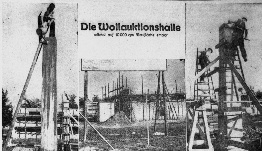
Der Betonpfeiler muß alle ein bis zwei Stunden gegossen werden. Der Unterbau nimmt bereits Form an. Aufnahmen: Müller
