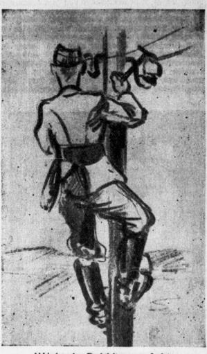
Abbinden der Drahtleitung am Isolator
