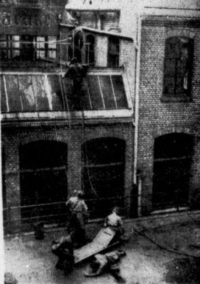
Feuerwehr- und Sanitätstrupp werden eingesetzt
