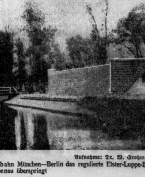
Die Wollager der Brücke, mit der die Reichsautobahn München-Berlin das regulierte Elster-Uppmann bei Kleinleisna überbringt
