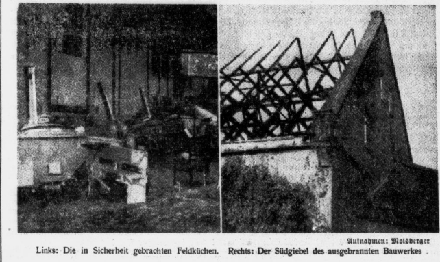
Links: Die in Sicherheit gebrachten Feldküchen. Rechts: Der Sügiebel des ausgebrannten Bauwerkes
