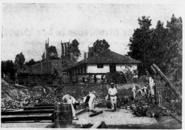
Die Arbeiten an dem Bau des Olympischen Dorfes bei Biberitz schreiten rüstig fort. Ein großer Teil der 140 Wohnhäuser ist bereits fertiggestellt
