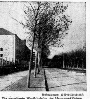
Die neuerbaute Westfahrbahn der Hermann-Göring-Straße
