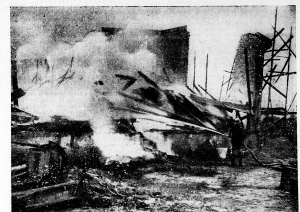
In kurzer Zeit waren die Gebäude ein Trümmerhaufen. (Aufnahme: Ziegler)
