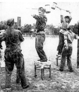
SA-Pioniere beim Bau eines Flandernzaunes.
