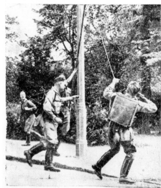
Nachrichtentrupp bei der Verlegung von Feldfabel.
