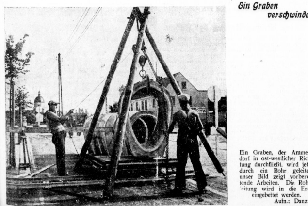
Ein Graben der Ammendorfer in ost-westlicher Richtung durchschließt, wird jetzt durch ein Rohr geleitet; unser Bild zeigt vorbereitende Arbeiten. Die Rohrleitung wird in die Erde eingebettet werden. Aufn.: Danz
