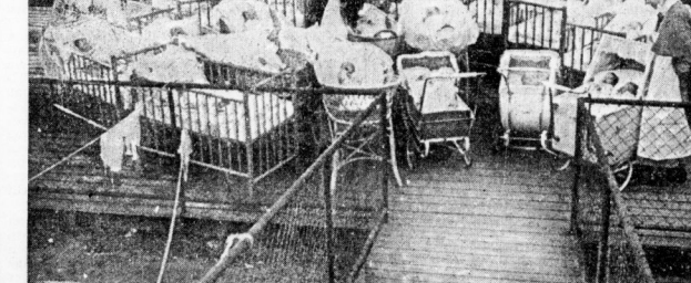
Bei dem Umbau und der Neueinrichtung des Mütterheimes der Halleschen Stadtmision wurde auch dieser schöne Dachgarten geschaffen.
