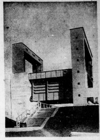
Außenansicht des Hebesäulen (Aufn.: Schirner)
