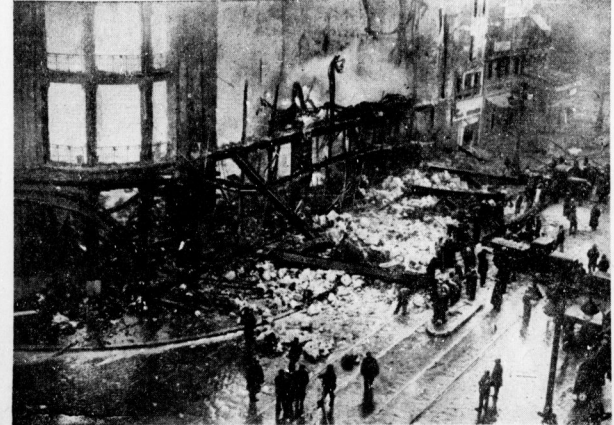
Die große Brandkatastrophe in Marseille: Links: Die Aufräumarbeiten vor dem völlig zerstörten Warenhaus Nouvelles Galeries. — Rechts: Feuerwehrmänner bei den ersten Bergungsarbeiten. — (Presse-Bild-Zentrale)
