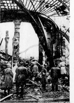
Die Aufräumarbeiten vor dem völlig zerstörten Warenhaus Nouvelles Galeries. — Rechts: Feuerwehrmänner bei den ersten Bergungsarbeiten. — (Presse-Bild-Zentrale)
