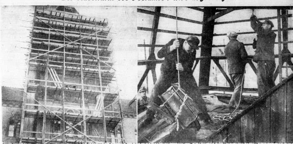
Wie schon ausführlich mitgeteilt wird der Kabelturm des Postamts 1 abgebrochen, weil er infolge der Verlegung der Kabel in die Erde überflüssig geworden ist und keineswegs zur Zierde des Stadtbildes dient. Unser links Bild zeigt den eingerüsteten Turm, das rechte berichtet davon, wie abgeschweißte Eisenstücke durch einen Schlingens in die Tiefe befördert werden. (Aufnahmen: Danz)
