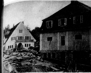
Neue Einfamilienhäuser entstehen auch am Giebichensteiner Ufer
