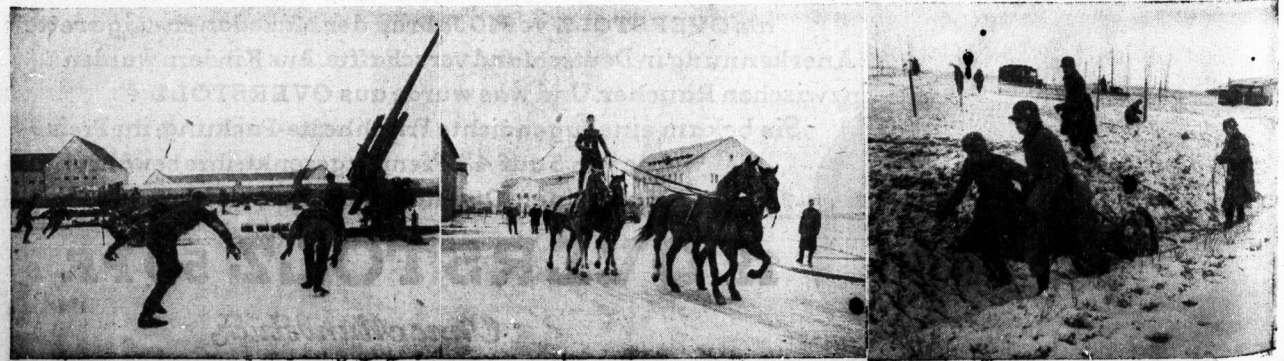
Von links nach rechts: Die Mannschaften einer schweren Flakbatterie gehen in Fliegerdeckung. — „Viersprung“ auf dem Marsch durch die Heeresnachrichtenschule. — Ein Funktrupp beim Verlegen eines schweren Feldkabels. Aufnahme: Danz
