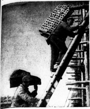
Mit hoher Last auf den Bau
