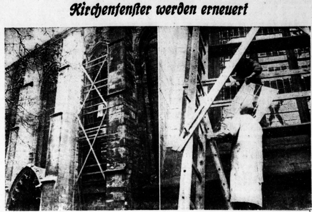
Kirchenfenster werden erneuert. An der Moritzkirche sollen die Fenster erneuert werden. Zunächst wird ein Fenster fertig gemacht...
