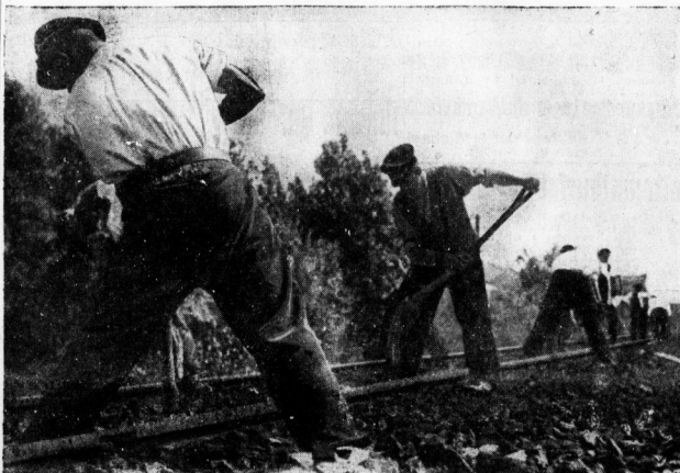
Arbeiten am Eisenbahnoberbau zum Zwecke der Verkehrssicherheit
