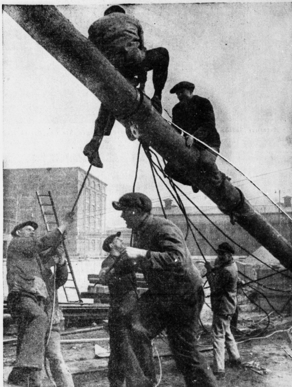
Beim Bauder Buna-Fabrik
