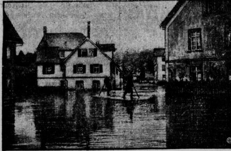
Die Uberschwemmungen in Oberschwaben nahmen vielfach den Charakter einer Hochwasserkatastrophe an. In Biberach wurde die Hauptstraße bis zu 1,50 Meter durch die Risse unter Wasser gelegt. Brücken müßten gesprengt werden, um ein Abfließen der Wassermengen zu ermöglichen. — Untere Aufnahme zeigt eine Straße in Biberach.
