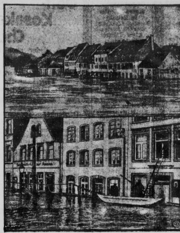
Oberes Bild: Der vollständig überflutete Stadteil 'Zur Laufen' in Trier. Unteres Bild: Eine überflutete Straße in Köln; die Bewohner klammern auf Leitern in ihre Wohnungen.
