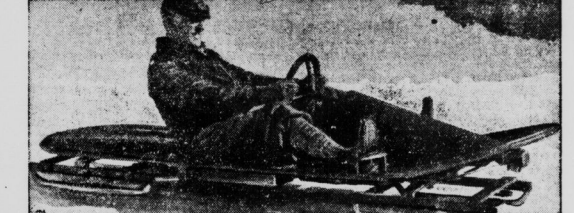
Der „Monobob“ — ein neues Winterport-Gerät: Der neue Einer-Woh mit Sandbremse, den der Schweizer Vobfahrer Hauptmann Feuerbacher konstruiert hat, erzielte bei den ersten Versuchen gute Zeiten.
