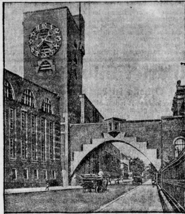
Unser Bild zeigt eine Zeitanstalt des neuerrichteten Verwaltungsgebäudes der S. G. Farbenfabriken in Höchst bei Frankfurt a. M.
