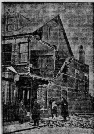
Unter Bild zeigt ein von dem heftigen Sturm der in den letzten Tagen über Süd-England tobte, schwer beschädigtes Haus im Distrikt Wallinghamton.
