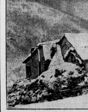
Eines der zerstörten Häuser von Dolomina (Alpen). das kürzlich von einer riesigen Lawine verheerter wurde.
