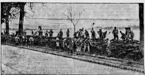
Die neue Ueberschwemmung der Gegend in Südwestfrankreich hat die Regierung veranlaßt, die höchsten Straßen und Bahnhöfen in und bei Bordeaux durch entsprechende Dämme zu schützen. — Unser Bild zeigt Pioniertruppen bei der Arbeit in der Gegend von Bordeaux.
