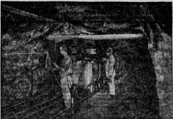
Salzförderung durch Grubenbühnen, die ein Aufzug in Umfang bringt. Ein solches Bergwerk wurde bei Wienburg durch den Erdsturz völlig fluglos.
