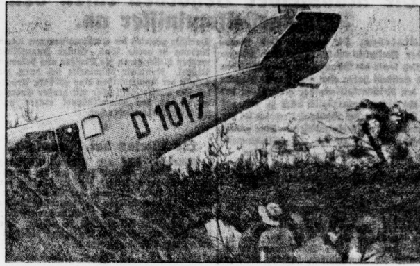
Infolge eines plötzlichen Motorendefekts mußte das Post- und Frachtflugzeug D 1017 im Grunewald bei Berlin mitten in einer Ackerflur notlanden. Der Geleitsgegenwart des Führers ist es zu verdanken, daß Personen nicht verletzt wurden und auch die Maschine nur geringe Beschädigungen erlitt.
