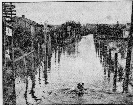
Böhmische überflutete Straße in der Kanonenkolonie Sophienstadt bei Berlin-Neukölln. Über 100 Menschen wurden hier durch den furiosesten Dauerregen obdachlos, deren Wohnstätten völlig überflutet worden sind. Das Wasser reicht in den Straßen bis zu 70 cm hoch, die Dampfkessel der Feuerwerke sind beinahe dauernd in Tätigkeit.
